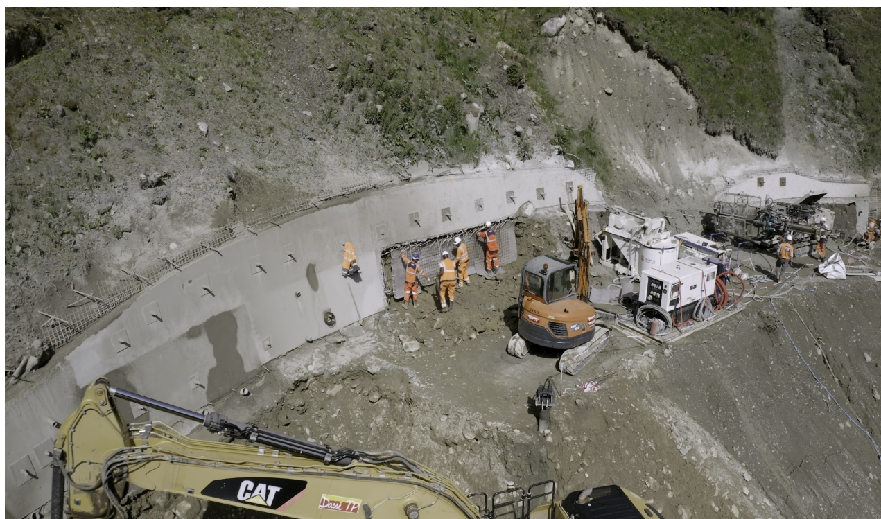
La paroi clouée
